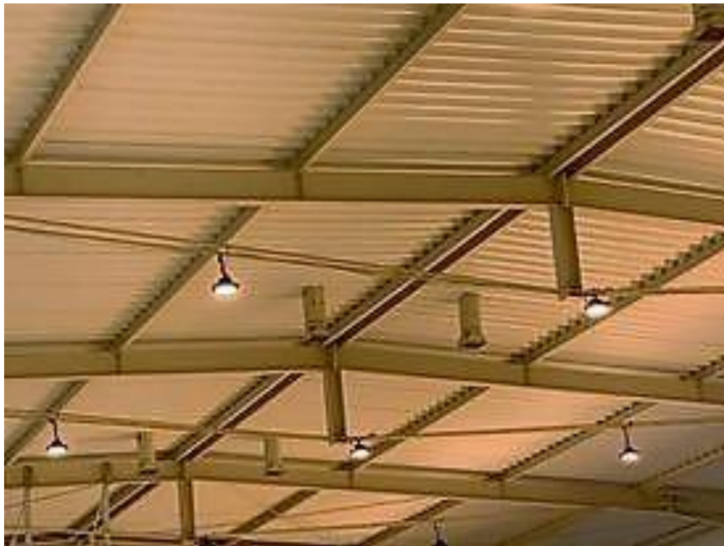
Zdjęcie 9. Wymiana oświetlenia na hali sportowej
