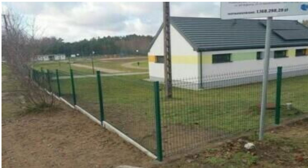
Zdjęcie 8. Wymiana ogrodzenia stadionu w Rąbinie
