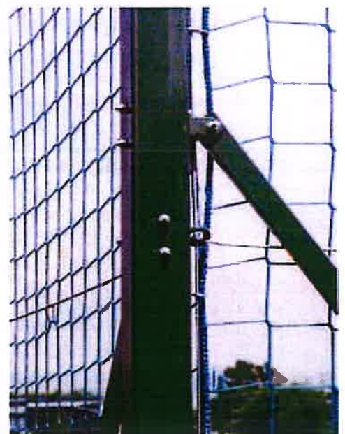
Przykładowy montaż stężenia oraz linki na skrajnych słupach
