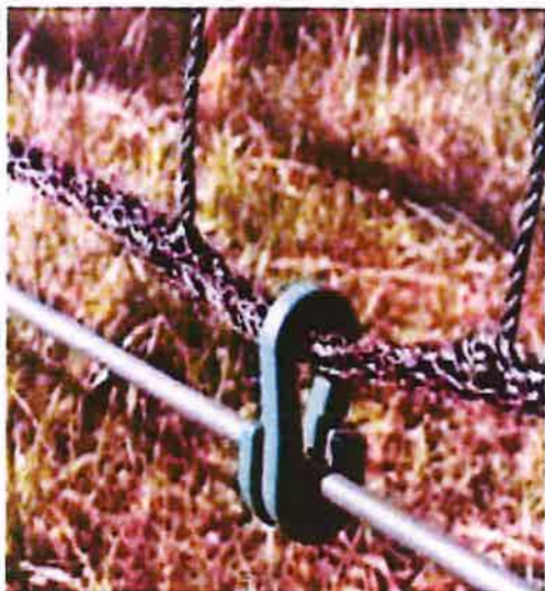
Przykładowy montaż siatki na linkach naciagowych - na zaczepach
