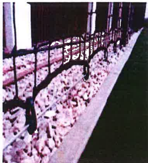
Przykładowy montaż siatki na linkach naciagowych - na zaczepach
