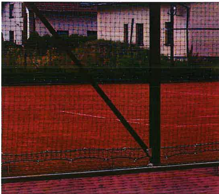
Przykładowy montaż stężenia oraz linki na skrajnych słupach
