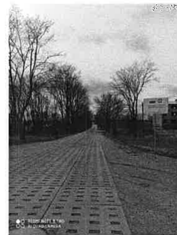
Zdjęcie 3. Droga w miejscowości Paszęcín
