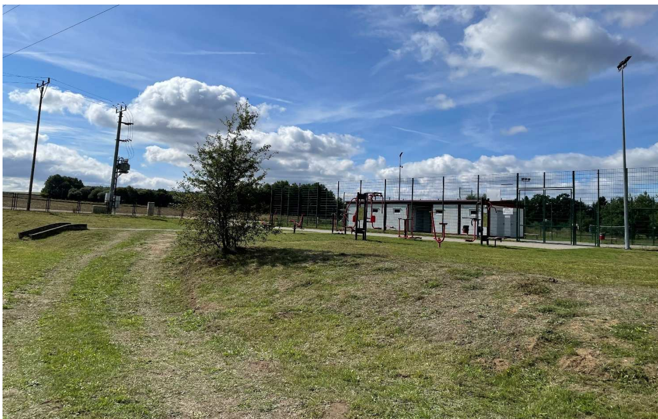
Istniejące infrastruktura od strony zachodniej boiska
