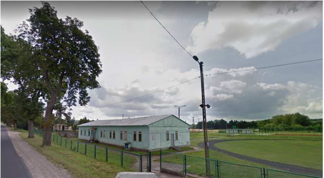
Istniejący budynek przeznaczony do rozbiórki, źródło: google.maps
