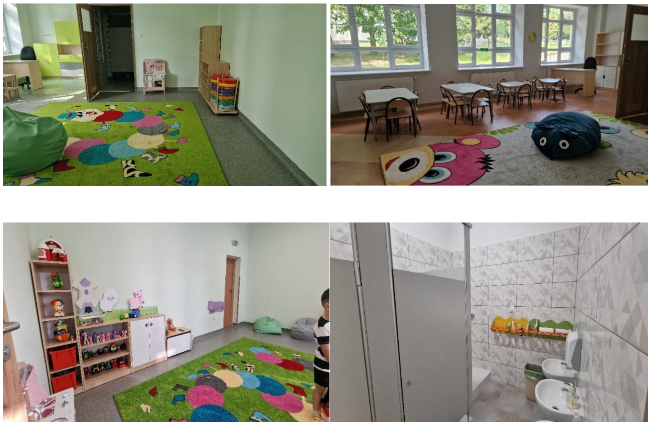
Zdjęcie 28. Remont przedszkola w Zespole Szkolno – Przedszkolnym w Rąbinie
