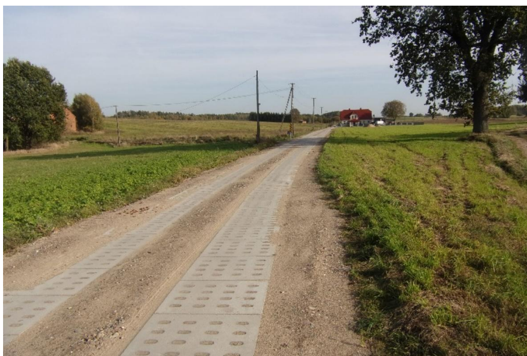
Zdjęcie 5. Droga gminna- Stare Ludzicko
