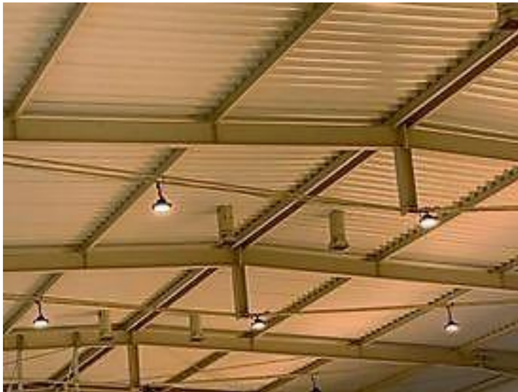
Zdjęcie 9. Wymiana oświetlenia na hali sportowej
