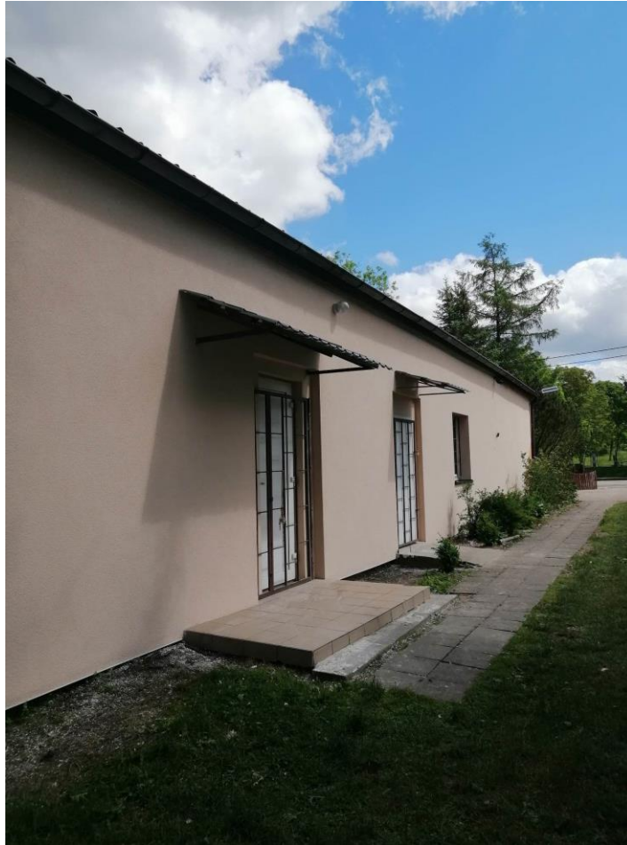
Zdjęcie 11. Remont świetlicy w Nielepie
