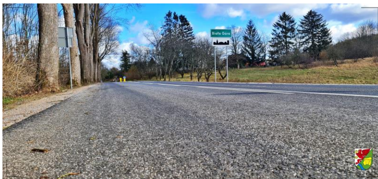
Zdjęcie 1. Droga powiatowa w Białej Górze
