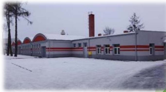
Centrum Kształcenia Praktycznego w Białogardzie po modernizacji
